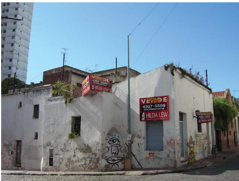
Fig. 1. Sitio actual correspondiente a la obra inédita de tapa (Fotografía, noviembre 2007)
